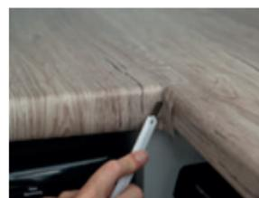
5. Folie mit dem Cutter zuschneiden bzw. abschneiden.
